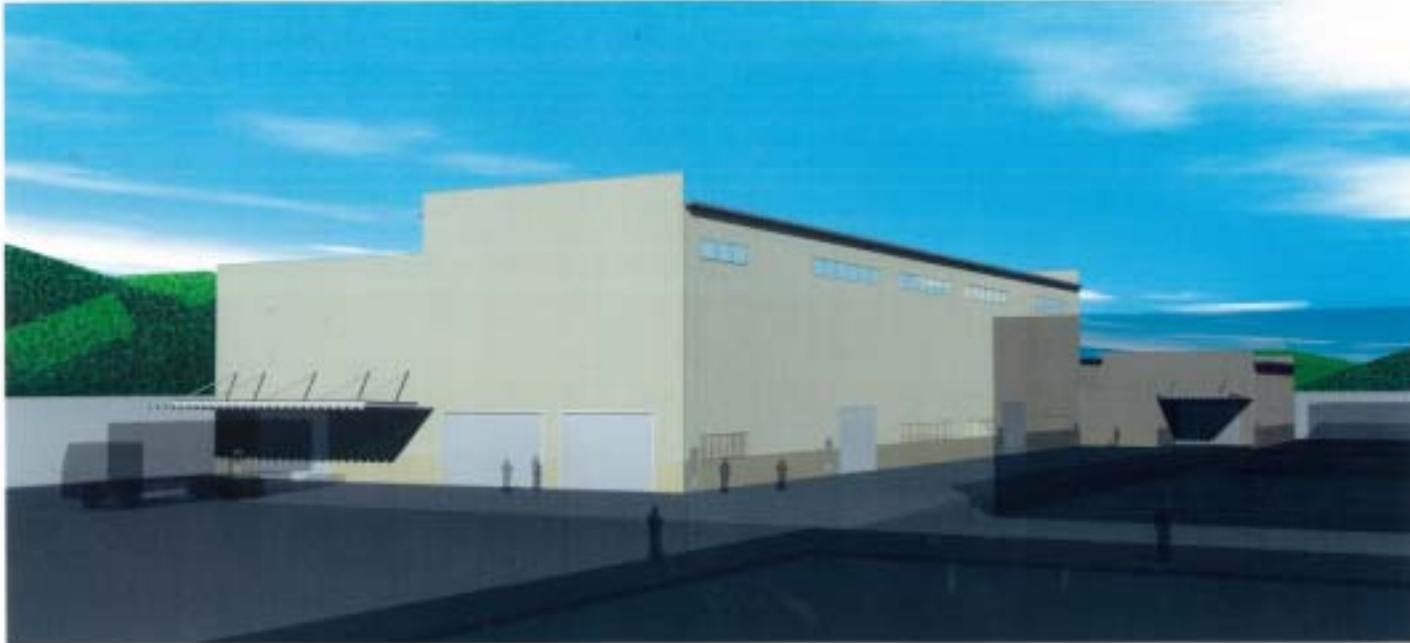
伊賀事業所 鋳物工場新築工事
