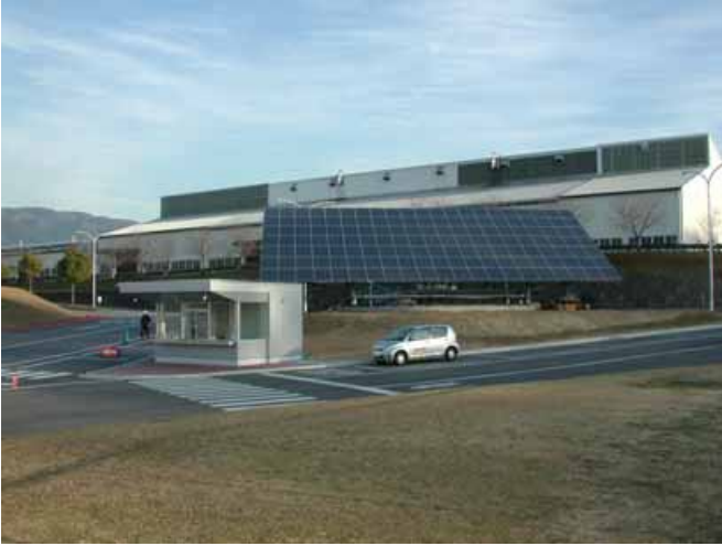
伊賀事業所に設置された太陽光発電装置
